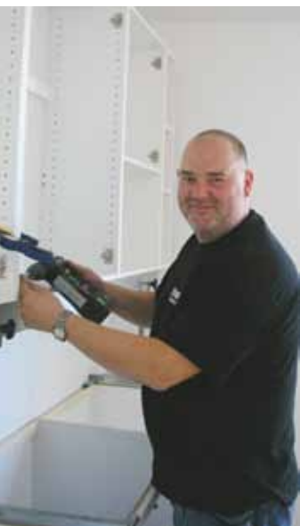
Olav-Håkan monterar köksskåp.
