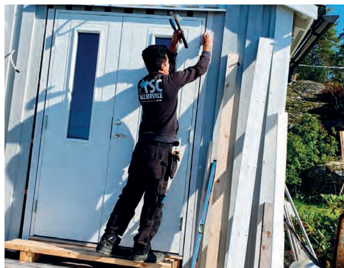
Snickare är efterfrågade – folk är extra villiga att renovera och bygga i den här pandemin. FOTO: INGELA JONSSON
